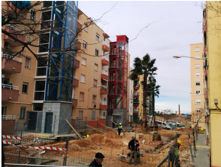
Figura 22. Obres als espais entre blocs
