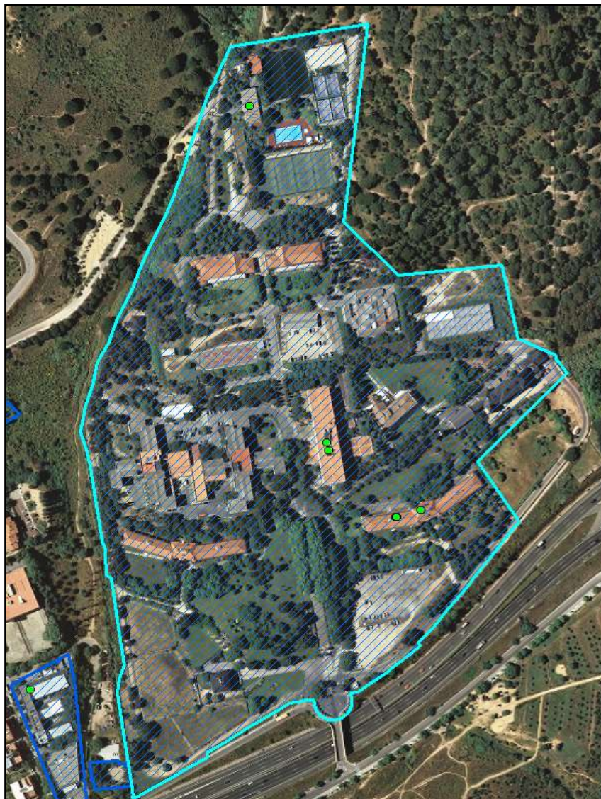
Recinte Torribera a Santa Coloma de Gramenet
