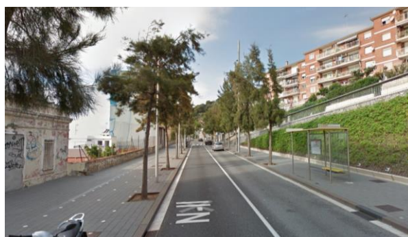
Exemple d'integració urbana de la N-II a Montgat. El conjunt d'actuacions han millorat la permeabilitat transversal de l'antiga NII, han pacificat aquest tram i han fomentat els mitjans de transport més sostenibles. Amb aquestes mesures s'ha constatat una reducció de la velocitat dels vehicles i disminuït consegüentment l'accidentalitat viària.
