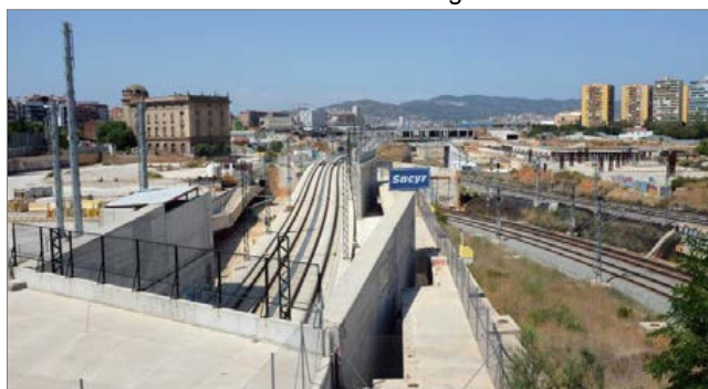
Obres eternes a la Sagrera
