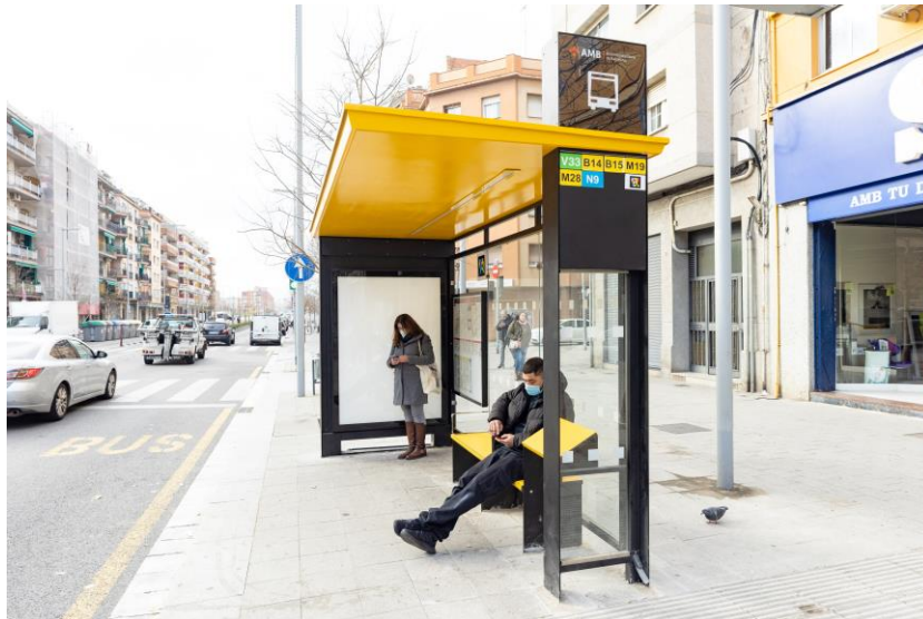
Imatge 8. Nou model de marquesina al bus metropolità. Font: AMB
